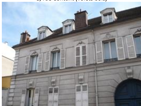
61, avenue Jean Jaurès (persiennes à lames horizontales)
