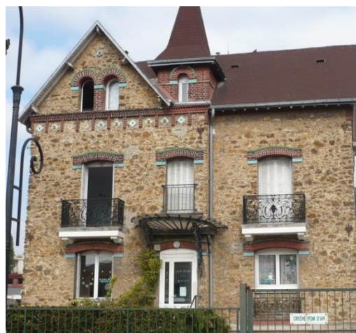
10, rue Léon Bry (losanges en céramique et briques décoratives des linteaux des baies)
