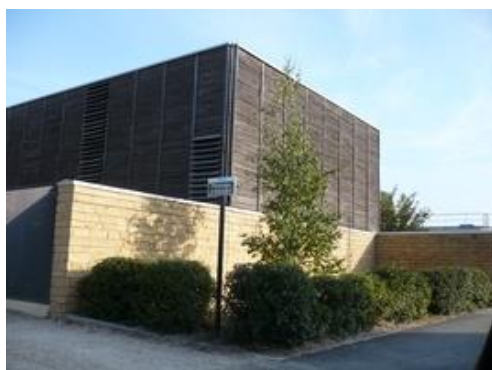
Usine de pompage eau potable, angle du passage d'Origny et rue d'Origny
