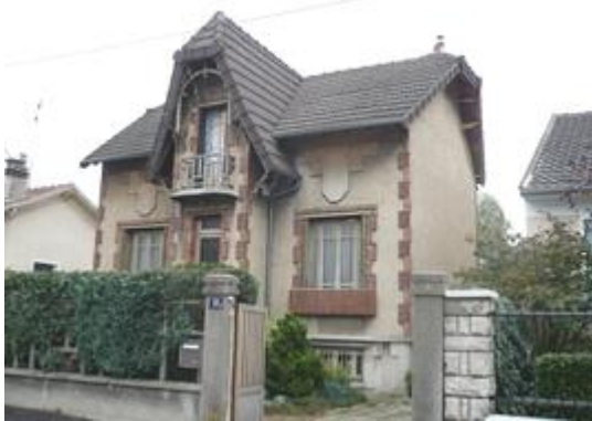
9, avenue de Provence 46
